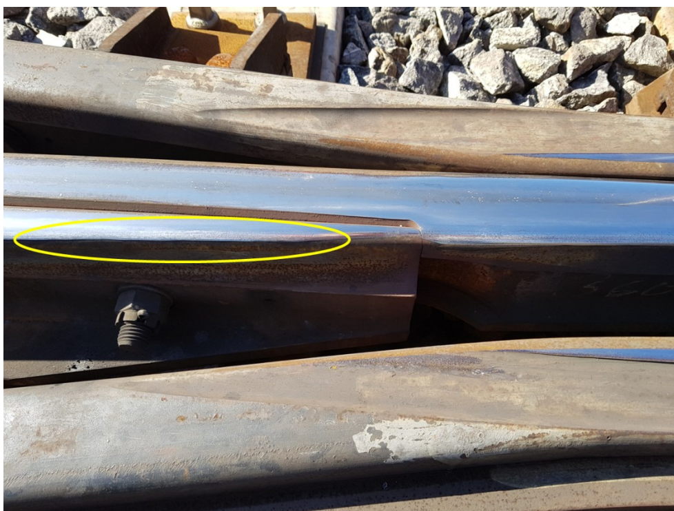
Obrázek 14 - Převalky na pohyblivém hrotu
