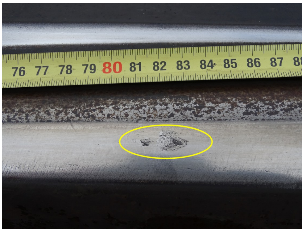
Obrázek 16 - Povrchové vady na hrotu srdcovky s PHS vzniklé prokluzem kol
