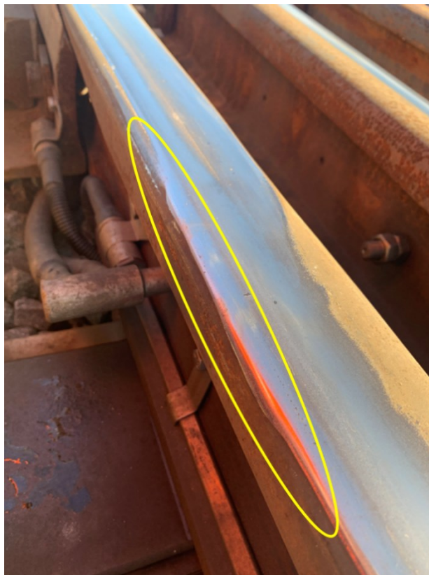
Obrázek 15 - Převalky na v oblasti dilatace hrotu
