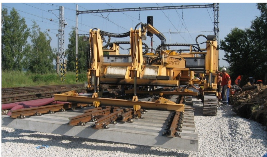
Obrázek 12 – Pokládka srdcovkové části pokladačem
