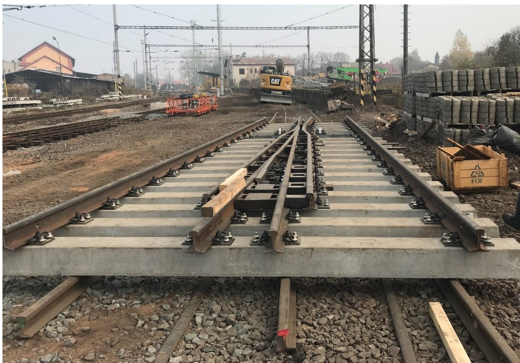
Obrázek 11 – Předmontáž srdcovkové části srdcovky s PHS na montážní základně (příklad montážního roštu)
